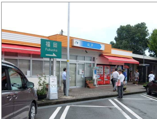
<閉鎖中(上り線)建物>
