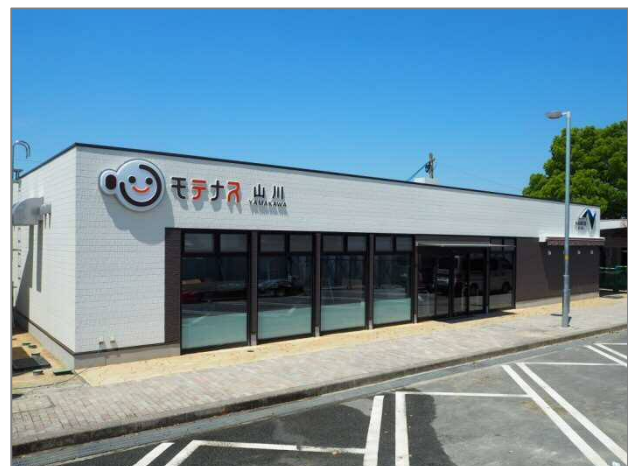
<リニューアル後(上り線)建物>
